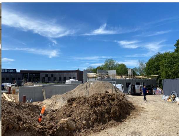
Byggepladsen d. 28. maj 2020
